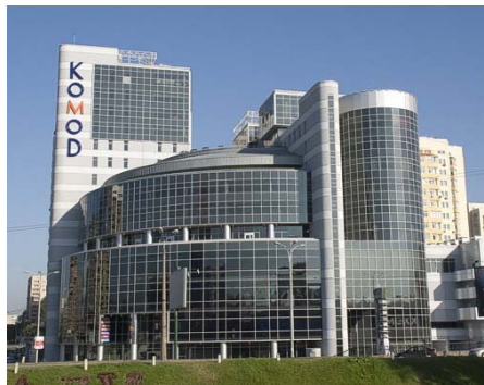
ТРЦ "Комод" (вул.Луначарського) інженерні системи магазинів, розважального центру
